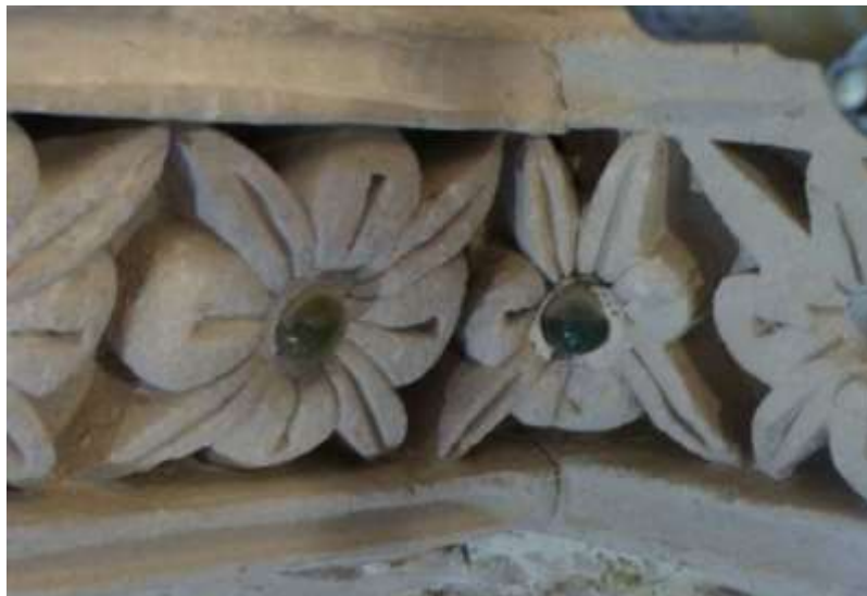
Piccole ampolle di vetro erano inserite nella decorazione a stucco e l'intera decorazione va immaginata colorata (restano tracce della policromia sulla cornice a stucco della parete orientale).
